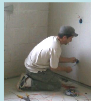
Le plombier, Électricien GRANGE Nicolas: le Bruffe 06 30 17 21 47 05 24 30 11 14
