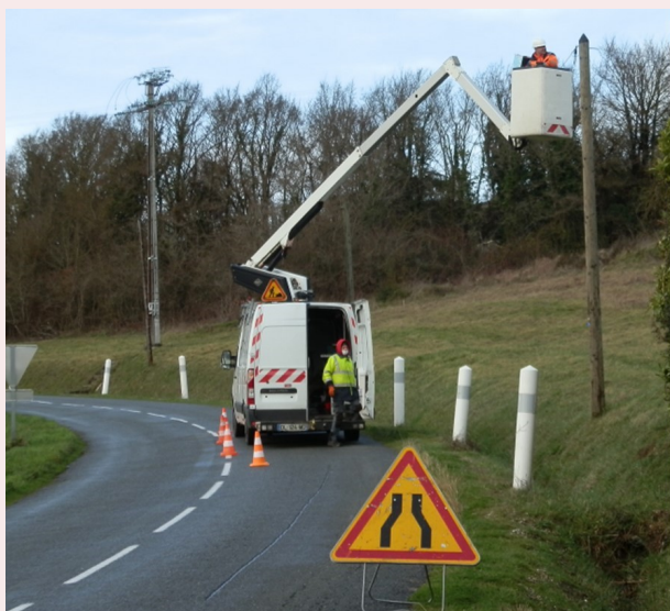
Installation de la fibre dans la montée de Bouglon
